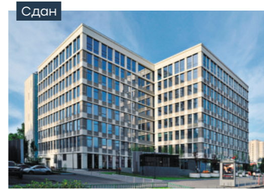
Бизнес-центр «Уолл Стрит»
