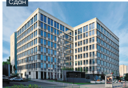
Бизнес-центр «Уолл Стрит»
