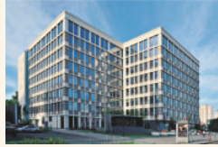
Бизнес-центр «Уолл Стрит»
