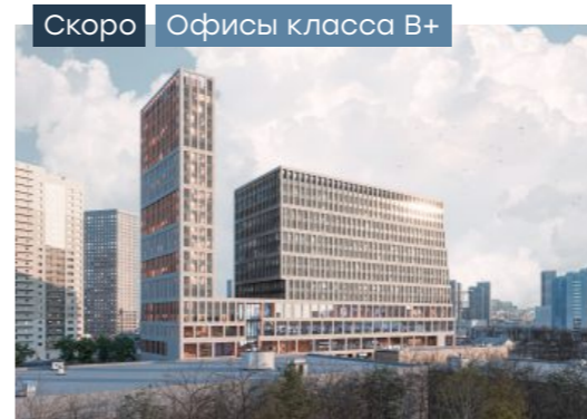
Level work Нижегородская
